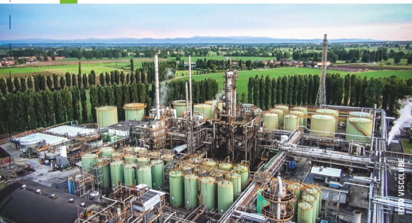
VEDUTA AEREA DELLA RAFFINERIA VISCOLUBE DI PIEVE FISSIRAGA (LO)
